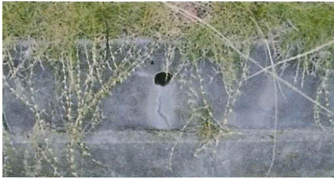
写真35. 水抜き管
