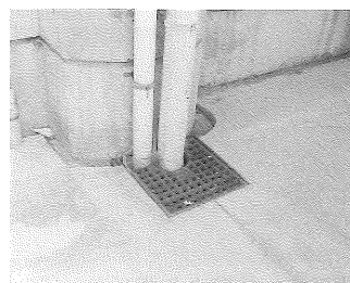
写真5. 雨水ますに防虫網を設置
