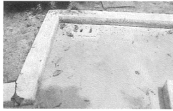
写真10. コンクリート地面に大量発生したため(100匹以上) 雨水ますを設置
